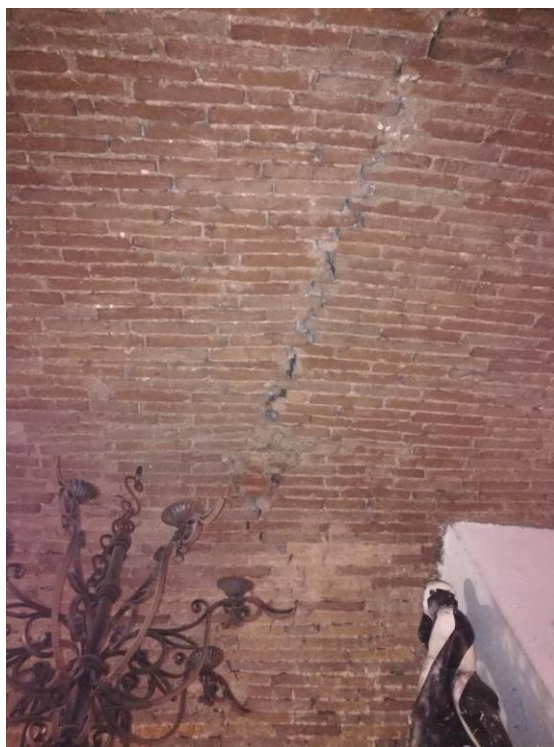
Foto 6 – Vista interna lesione vano Fabbro
